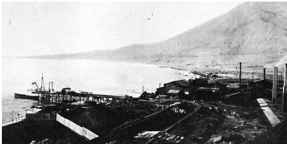
Figura 2. Ensenada de Gatico y su fundición, 1909. En primer plano, las vías ferroviarias que transportaban el carbón proveniente de Westfalia (Alemania) hasta la fundición y, de regreso, trasladaban el cobre refinado para su embarque. Al sur del muelle se distingue el botadero, donde se acumulaban las escorias de cobre. A la derecha, la casa de máquinas que producía la electricidad, los chancadores, la planta de concentración, los convertidores y los hornos de reverbero con sus respectivas chimeneas. Fotografía reproducida en Estadística minera de Chile: 1908-1909 (1910). Archivo Documental del Área de Investigación Histórico-Patrimonial Museo de Antofagasta.
