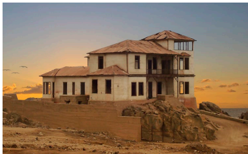
Figura 6. Estado actual de la casa de administración de la Compañía Minera de Gatico, construida en 1914. Fotografía de Esteban González Ferrer.
